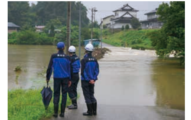
冠水により道路が寸断された前沢地区の現場を確認
