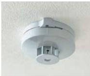
古くなった火災警報器は、バッテリーやセンサーなどの劣化により、火災を感知しない恐れがあります。10年経過する火災警報器は新しいものに交換し、火災の発生時に家族の命を守るようにしましょう。
