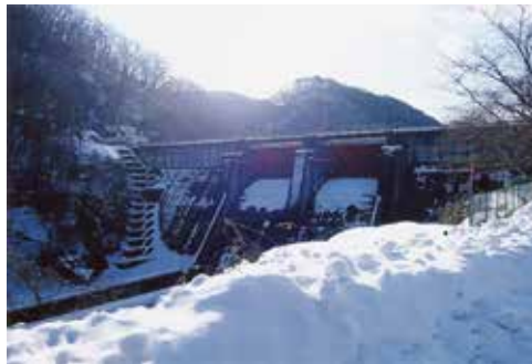
(河内ダム(2号ダム))
