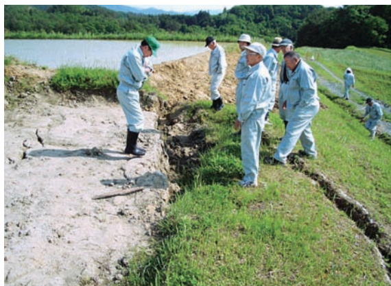
江刺区玉里六百刈田沢の水田のクラック、畦畔・法面の崩れ
