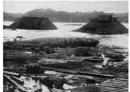
三陸大津波による被害の様子
