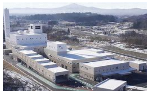
クリーンプラザよこて
