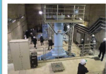
④利水・緊急放流ゲート室
