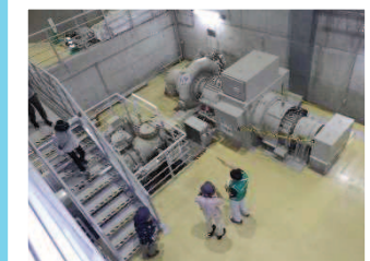
⑥胆沢第三発電所
