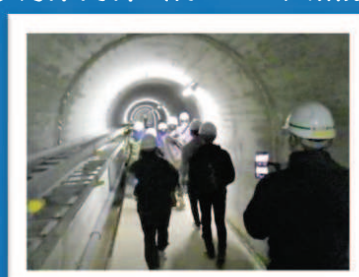
⑤堤体内部 (約800m、階段有)
