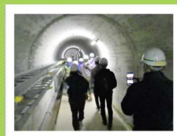
⑤堤体内部 (約800m、階段有)
