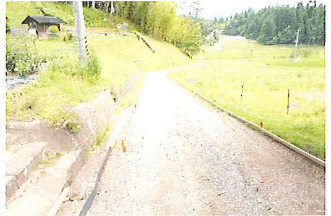
舗装前の砂利道
