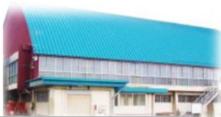
前沢スポーツセンター
