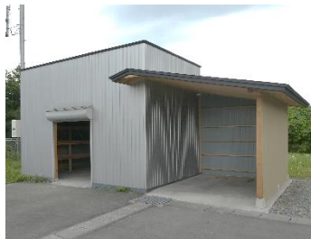
外倉庫 たたき・整理棚設置 倉庫脇 車庫建設等
