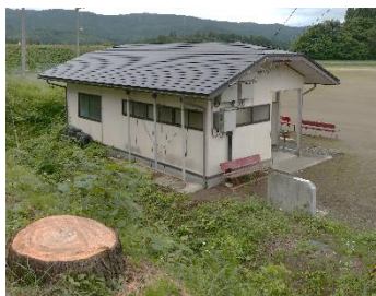
グラウンド 支障木伐採 物置屋根葺き替え
