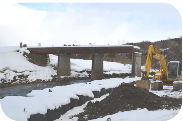
令和2年度から施工を開始した「女石橋」。
