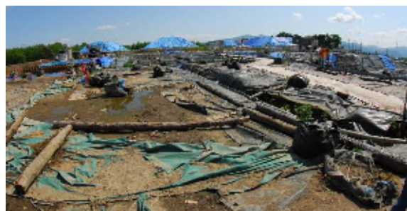
岩手県側は、ひとまず今年度で一定処理が完了する予定とのことでした。投棄現場の面積の大きさに唖然。
