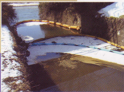
油の回収作業の様子
