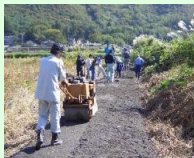
未舗装農道の舗装
