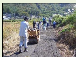
未舗装農道の舗装
