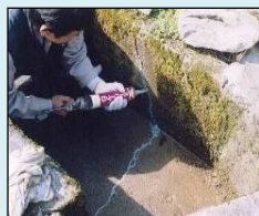
ひび割れの補修
