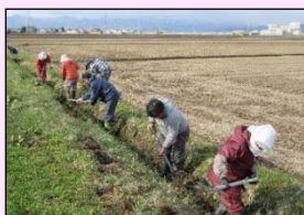
水路の泥上げ
