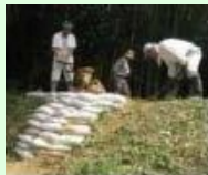
漏水箇所の補修
