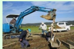
コンクリート水路の更新
