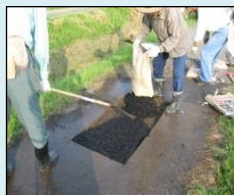
農道の部分補修
