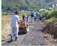
未舗装農道の舗装
