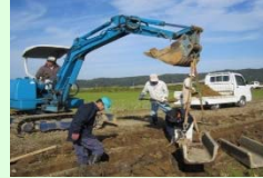
コンクリート水路の更新
