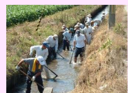
水路の泥上げ
