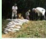
漏水箇所の補修
