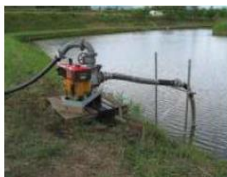
応急ポンプの設置・運転
