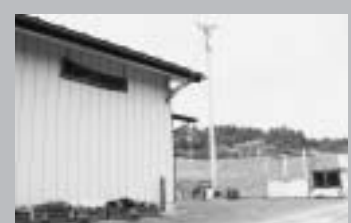
放送設備などの備品整備が行われた新田コミュニティーセンター（前沢区生母）
