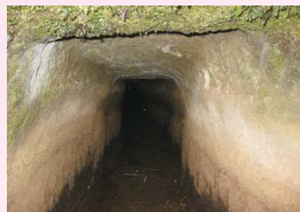
大平裏隧道の内部の様子
