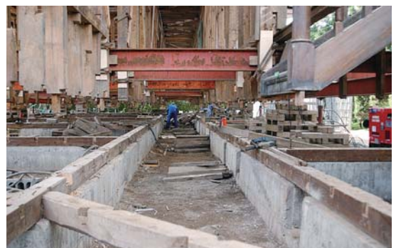
骨格だけとはいえ約70トもある建物がジャッキで持ち上げられる
