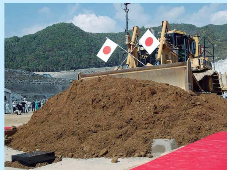
大型フルドーザーによりダム堤体基礎部分に埋め込まれる礎石
