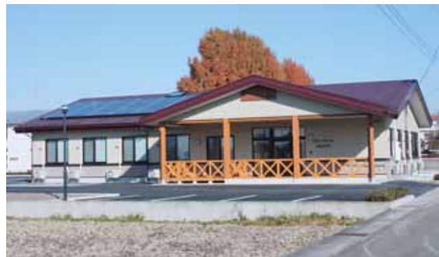
太陽光発電システムを設置した「ひだまり2」
