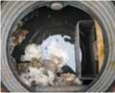
清掃前の浄化槽
