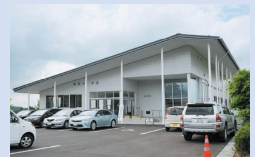
完成した藤里地区センターの外観
