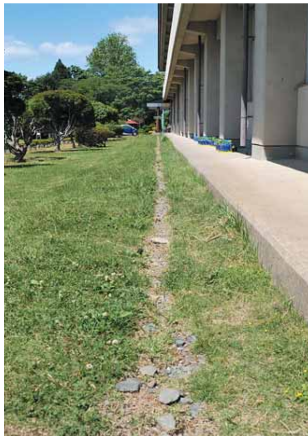
除染を行った稲瀬小学校の校舎南側軒下付近
