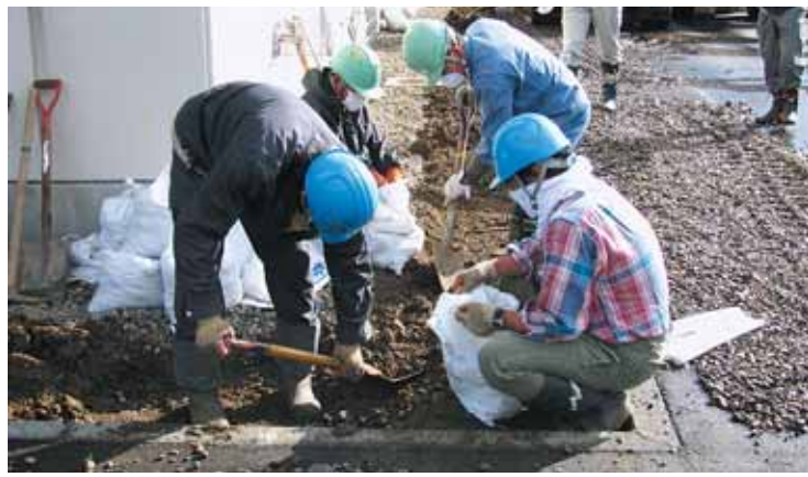
除染作業の様子
