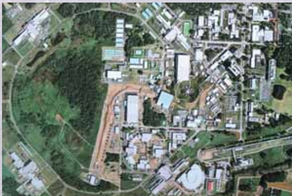
KEK施設地下に1周3キロの加速器が設置されている
