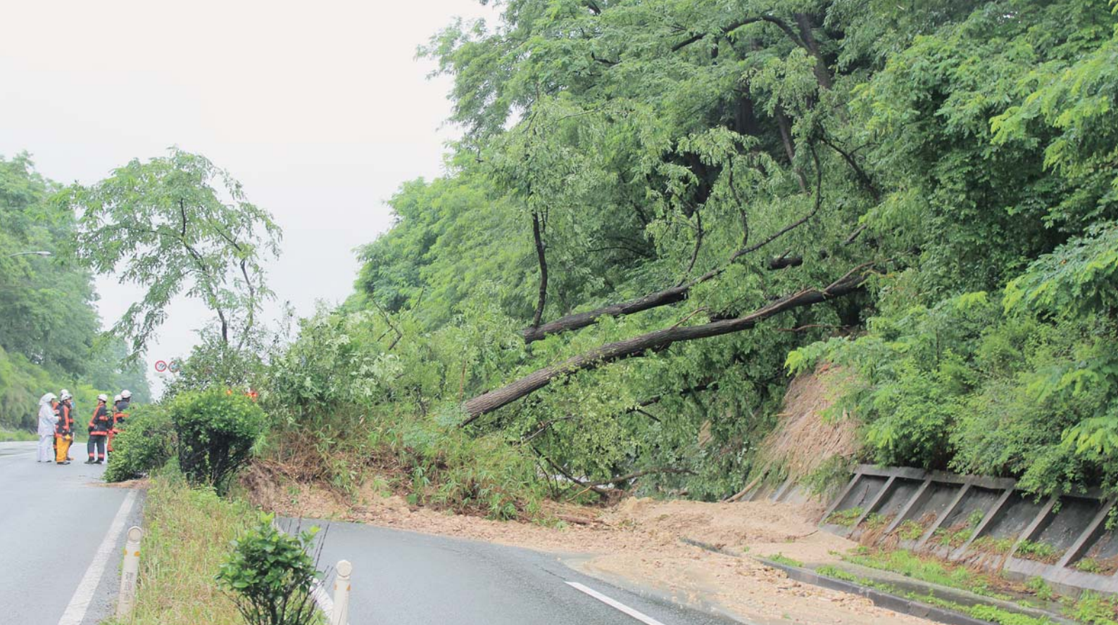
前沢区字徳沢地内で7月27日に発生した国道4号の土砂崩れ。こんなときに、システムを利用していち早く情報を確認できます
