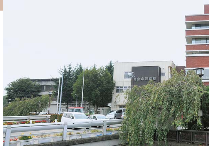
経年劣化による老朽化が進む水沢病院
