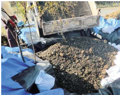
除染で出た汚染土などは安全に埋設
