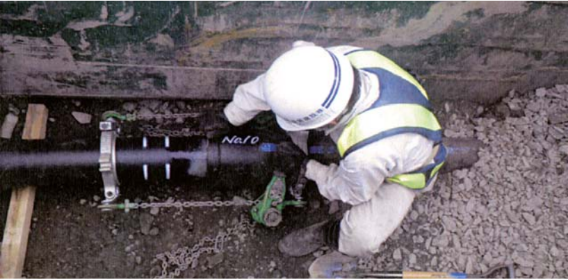
【老朽管更新工事：新たに耐震管を布設する作業員】
