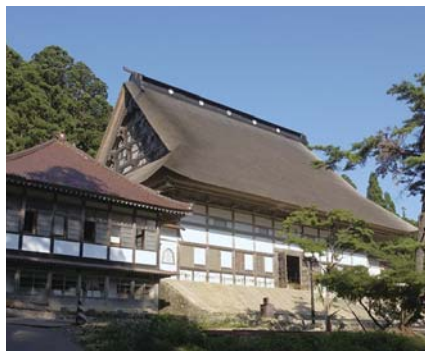
平成の大改修を終えた正法寺本堂
