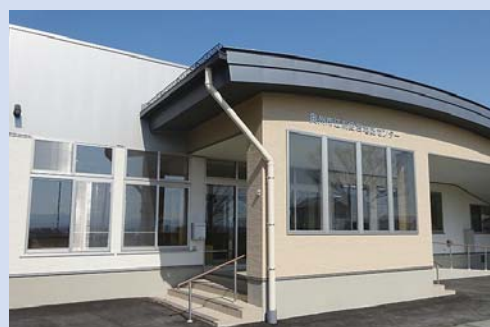
供用を開始した江刺愛宕地区センターの外観
