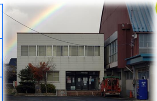
前沢スポーツセンター
