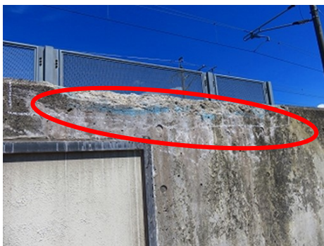
コンクリートの欠損
