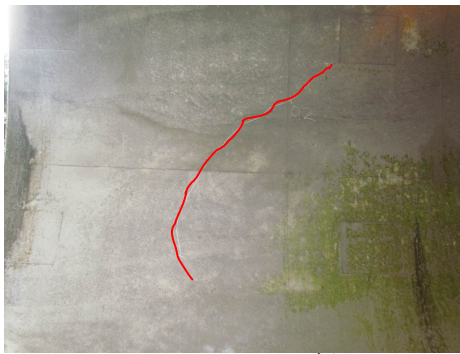
コンクリートのひび割れ
