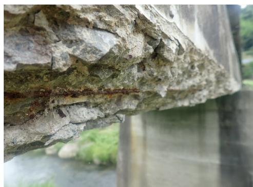
主桁に断面欠損が発生
