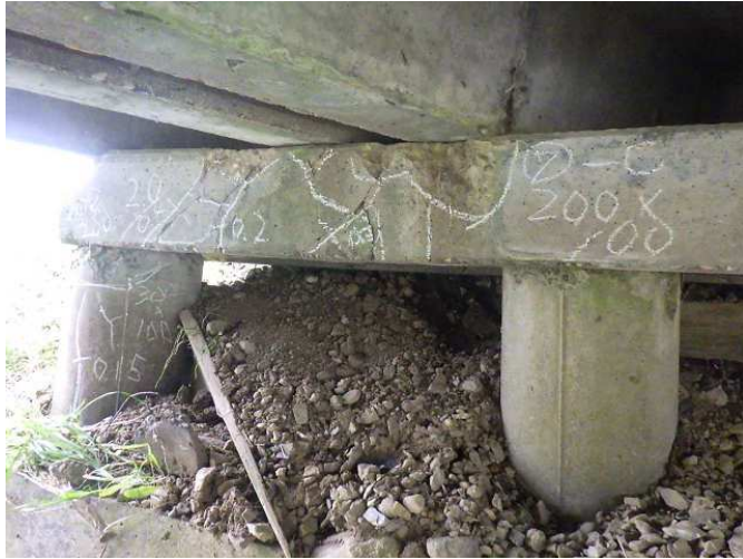
コンクリート部材のひび割れ
