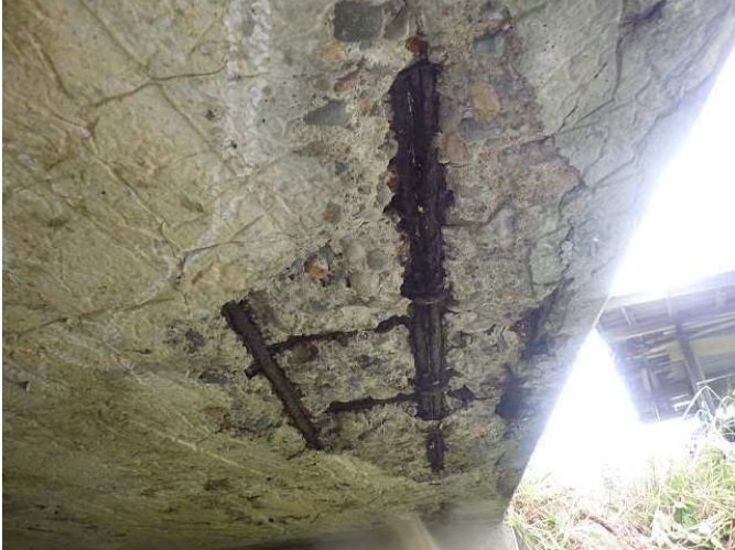
コンクリート部材の断面欠損
