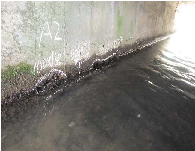
コンクリート部材の断面欠損
