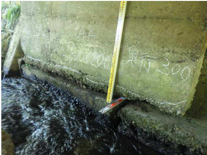
コンクリート部材のひび割れ
