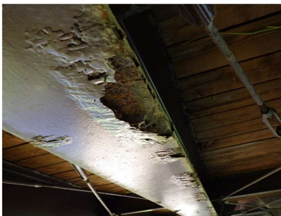
鋼部材の腐食
