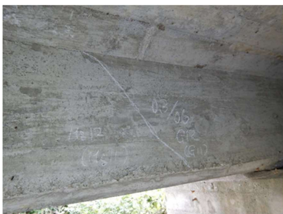
コンクリート部材のひびわれ
