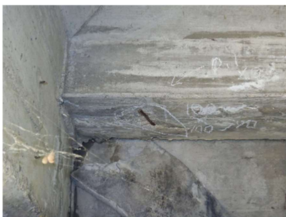
コンクリート部材の鉄筋露出
