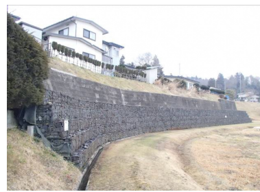
【災害防止措置の状況】 盛土等に施工された災害防止措置(対策工)は、十分機能しているか
