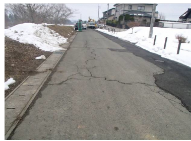
【盛土上部の状況】 盛土の上部に亀裂、段差、沈下等の減少や路面の補修跡が確認されないか
