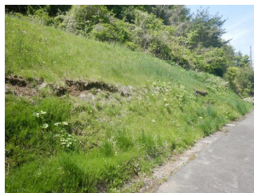
【盛土等法面の状況】 崩壊跡、肌落ち、浸食等の盛土崩壊の前兆となる現象が確認されないか
