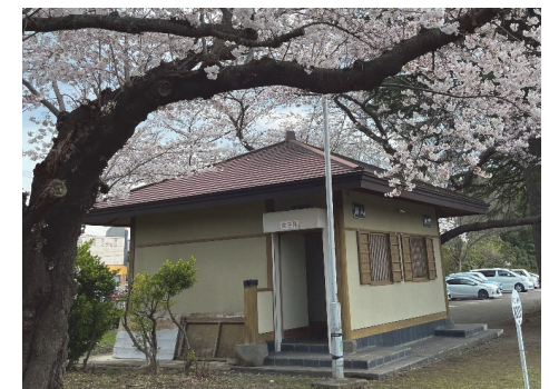
▲ バリアフリー未対応のトイレ(東トイレ)
