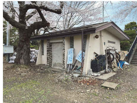
▲ 老朽化した備品倉庫
