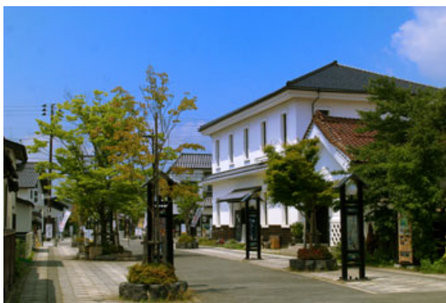
古い蔵を改修した街並みが続く蔵まちモール
