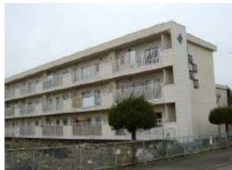
市営住宅 川端住宅
