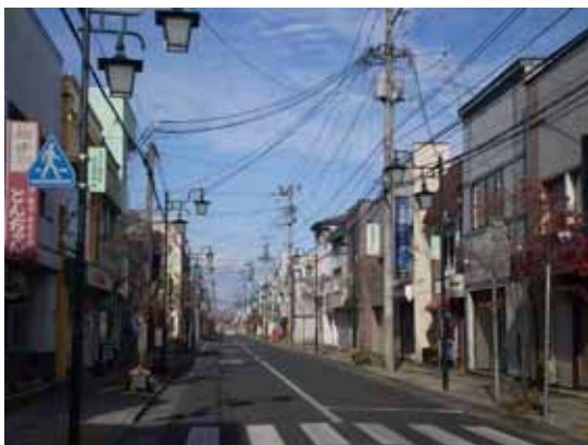
景観を阻害する電線・電柱
