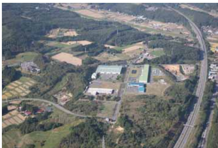
前沢インター工業団地
