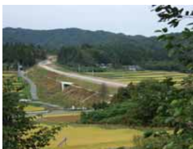
(仮称) 江刺田瀬インターチェンジ予定地付近
