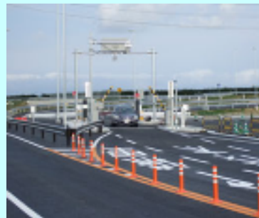
水戸北スマートIC(常磐自動車道)
