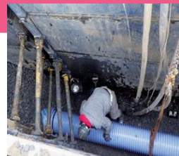
社会資本整備 総合交付金事業 [水沢] 真城が丘処理分区分水ノ口前 地区管渠築造工事
