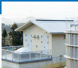
創設事業 [江刺] 新藤里配水池薬品注入棟
