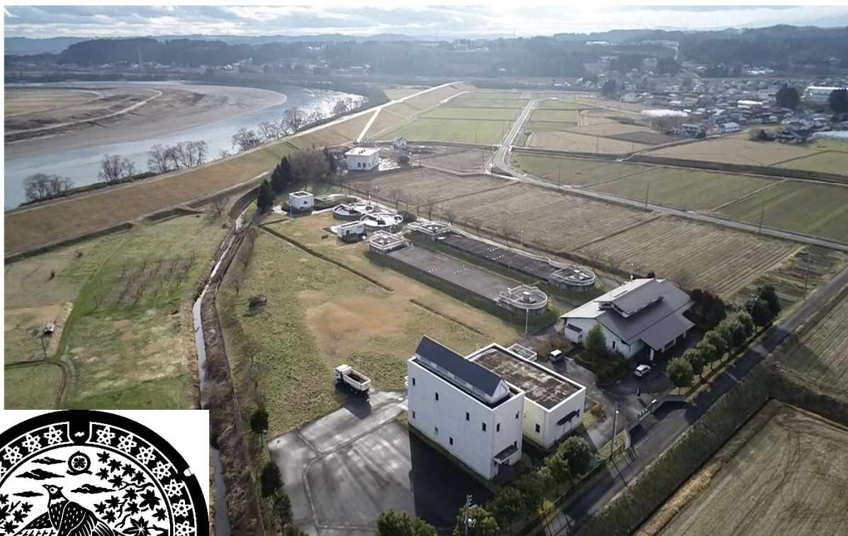
前沢下水浄化センター
