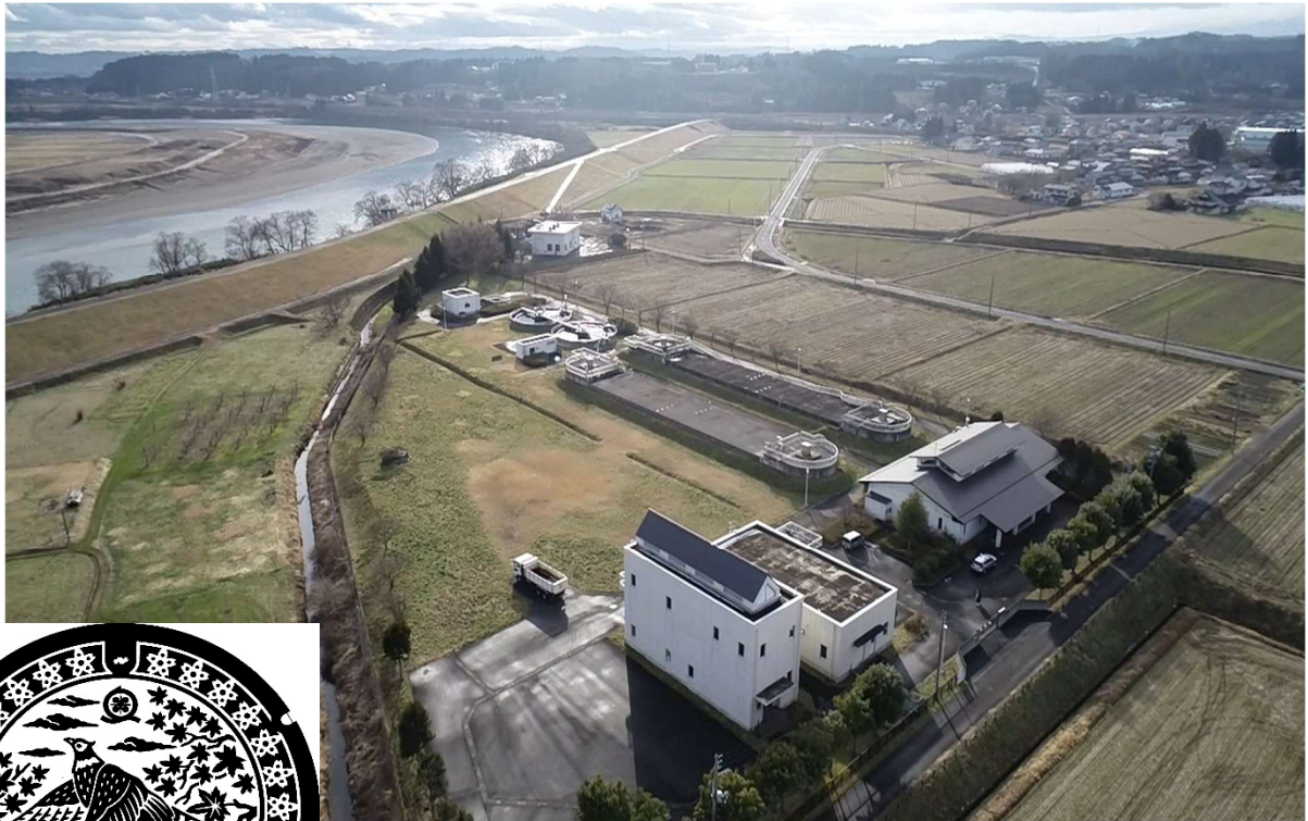
前沢下水浄化センター
