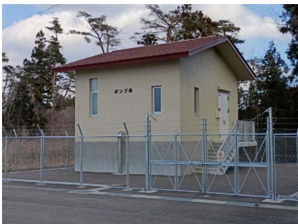
新深沢ポンプ場
