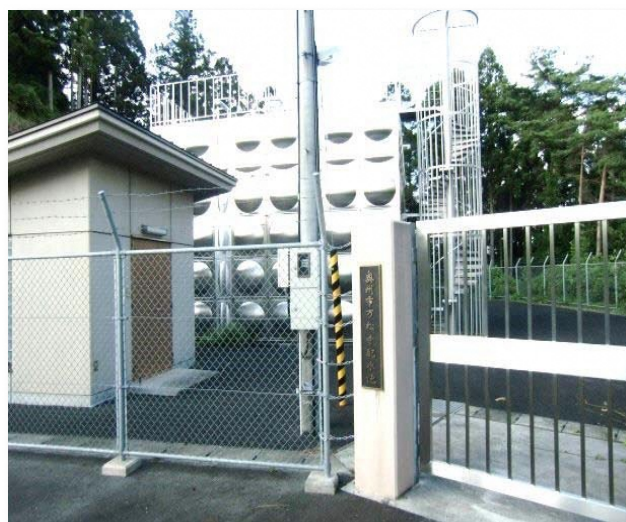
万松寺受水配水池
