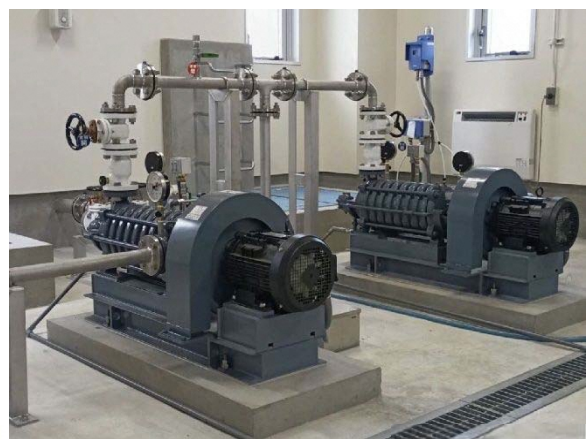
ポンプ設置状況
