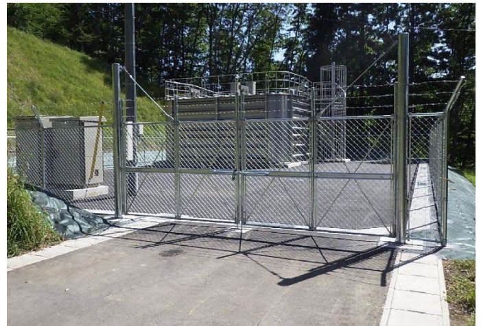
新分限城配水池
