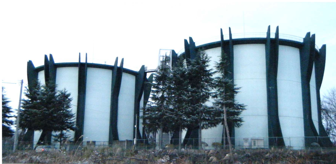
【桜屋敷配水池】
