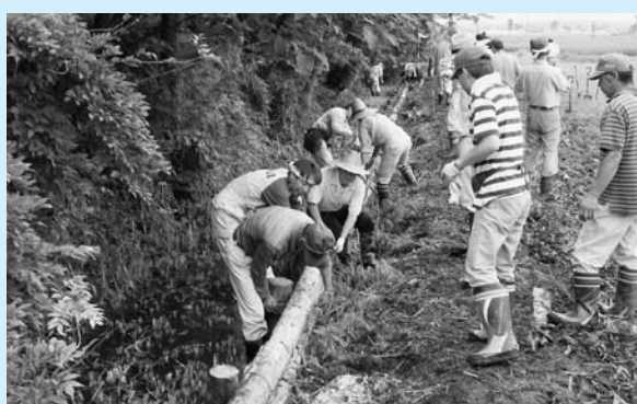
水路管理のために土留めの丸太を設置（水沢区）
