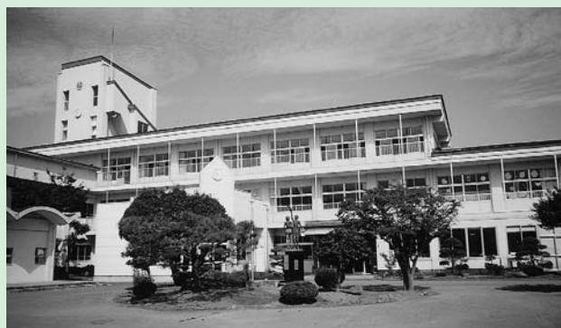
今年度耐震補強工事が行われる胆沢第一小学校（胆沢区）
